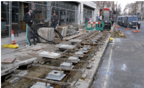
Abbildung 53: Tiefbauarbeiten für Barclays Cycle Hire 2 (Fotos: TfL)
