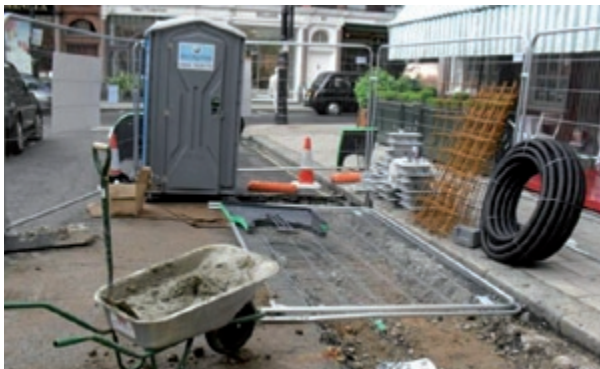
Abbildung 52: Tiefbauarbeiten für Barclays Cycle Hire 1 (Fotos: TfL)
