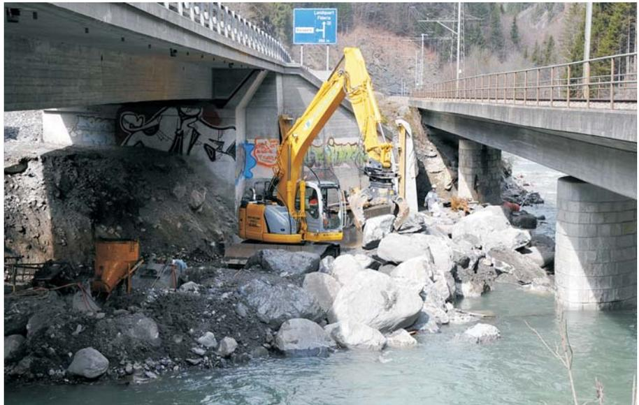
*Bau der Stützmauerfundamente zwischen Bahn- und Strassenbrücke*
