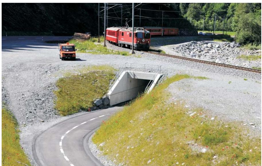
*Die fertig hinterfüllte und eingedeckte Unterführung Äuli*
