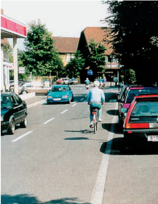
5: Mischverkehr auf einer Hauptstrasse in Lustenau (A). Beim Umbau konnten kleine Flächengewinne zugunsten des Fussverkehrs und der Strassenraumgestaltung realisiert werden. Die mit 10 000 DTV und einem Busanteil von ca. 3 % belegte Fahrbahn ist 6 m breit und mit einer Geschwindigkeitsbeschränkung von 40 km/h signalisiert.
