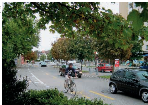
7 7: Dank der Reduktion von 6 auf 2 Fahrspuren wurde ein grosszügiger Radstreifen ausgeschieden und eine Mittelallee gepflanzt. 7: Grâce à la réduction de 6 à 2 voies il a été possible de dégager une bande cyclable confortable et de planter une rangée médiane d'arbres d'alignement.
