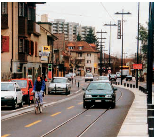
6: Beim Umbau der Seftigenstrasse in Wabern wurde die bestehende räumliche Trennung zwischen MIV und Tram durch eine Mischverkehrslösung mit zeitlicher Trennung ersetzt. Der Verkehrsablauf im MIV wird durch das Tram beeinflusst und mit geringem technischem Aufwand gesteuert. Die 20 000 DTV können mit dieser Lösung weitgehend störungsfrei abgewickelt werden. Für die Seitenräume und den Radverkehr wurden grosse Flächengewinne erzielt.
