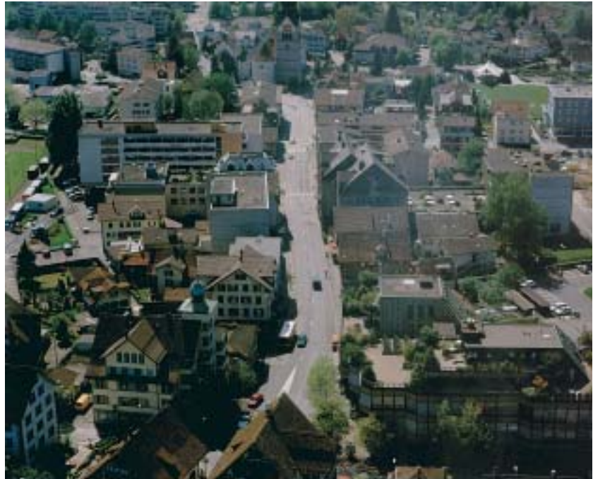
monotoner Strassenzug ("Durchfahrtsstrasse")
