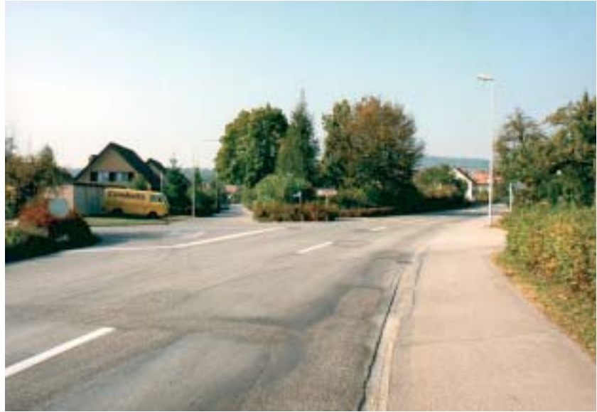
Dorfeinfahrt mit unübersichtlicher Einmündung
