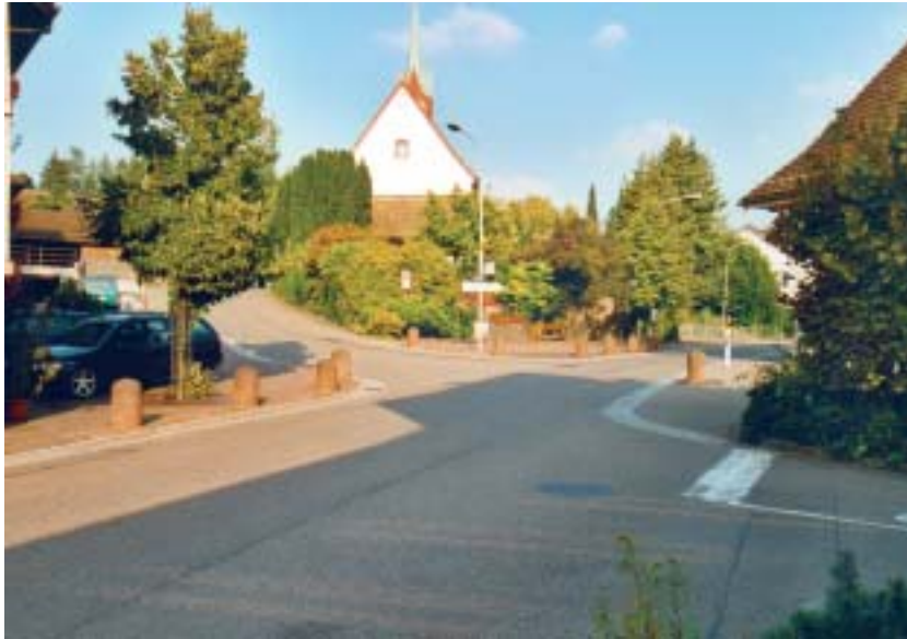
redimensionierte Einmündung, geschützt mit Wehrsteinen
