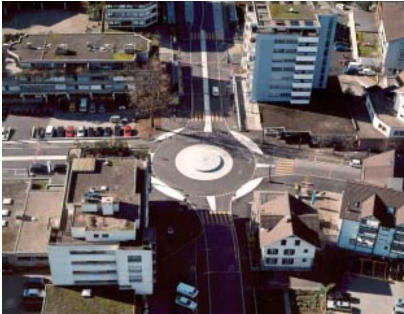
Kreiselanlage und Strassenraumgestaltung schafft Zentrumsatmosphäre
