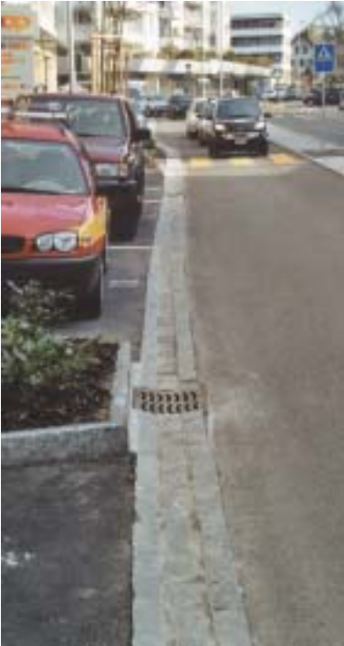
Längsparkierfelder im Zentrumsbereich
