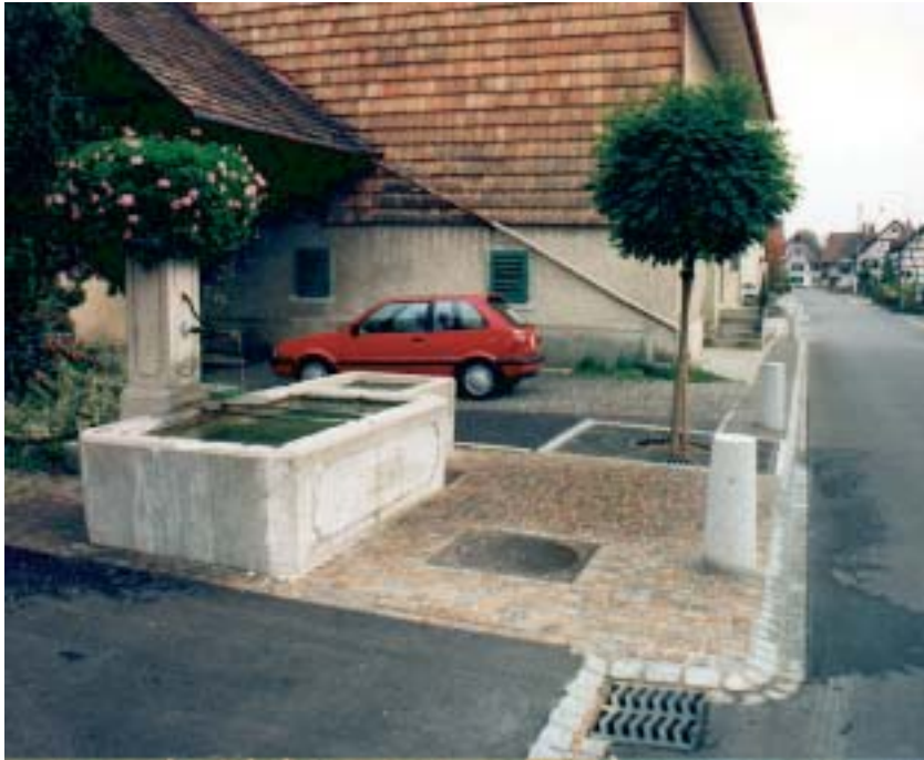
Dachsen (ZH): Fahrbahnverengung bei Brunnenplatz
