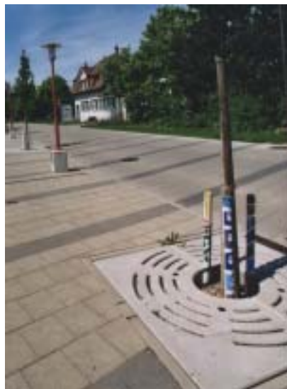
Betonelemente und Metallrost
