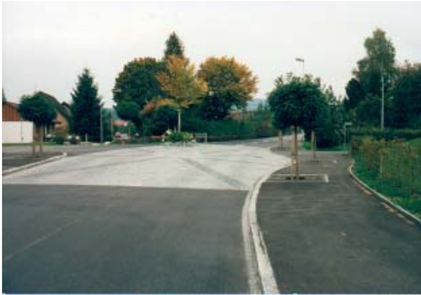
Eingangspforte mit Mittelinsel und Pflästerung
