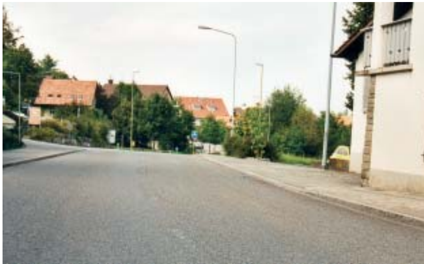
Entfernung der Mittelstreifenmarkierung
