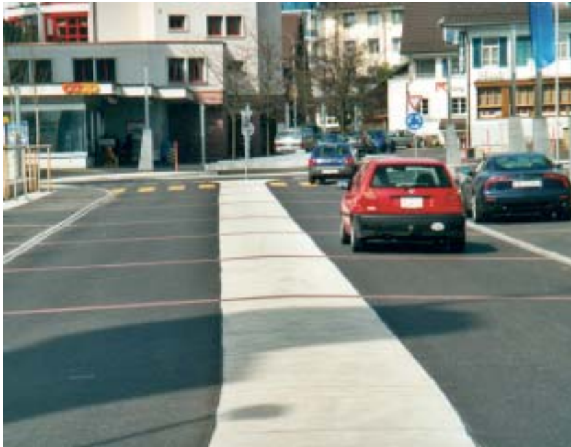
Strasse mit Verkehrstreifen in Fahrbahnmitte, Steinhausen (ZG)
