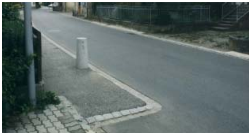
Fahrbahnverengung mit Wehrstein
