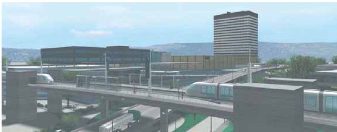
Haltestelle «Messe/Hallenstadion» (kleines Bild) der ersten Etappe der Glattalbahn sowie beim Glattzentrum (3. Etappe)
