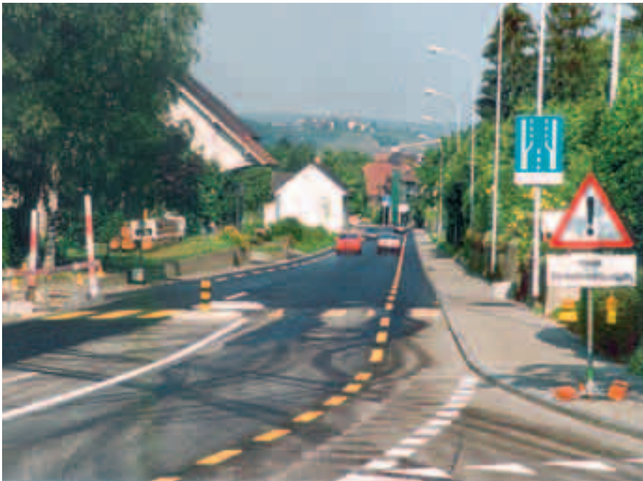
Abb. 35: Kernfahrbahn: Neuverteilung der Flächen statt Strassenausbau.
