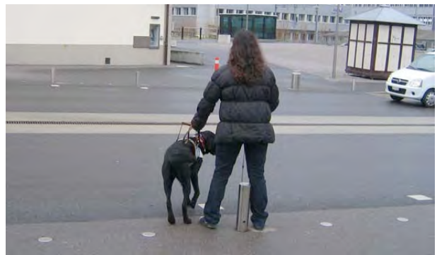
Pfosten visuell und taktil nicht erkennbar
