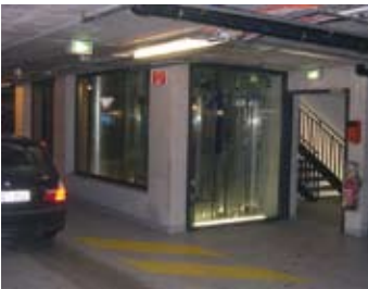
L'utilisation du verre pour l'ascenseur et la cage d'escaliers favorise la visibilité et une bonne transparence (parking Gessnerallee, Zurich ; photographie par Doris Königer).
