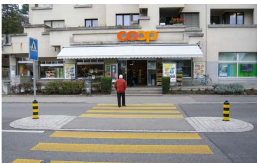
Le passage pour piétons est situé sur la trajectoire naturelle des piétons, juste devant le magasin. Il est équipé d'un îlot central (Bassersdorf, ZH).
