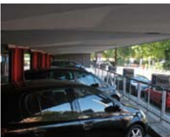
La lumière du jour engendre une atmosphère agréable (parking quai de la Sihl, Zurich).
