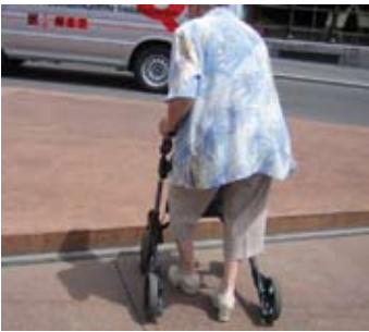
L'absence d'un abaissement du trottoir pose problème aux personnes à mobilité réduite.
