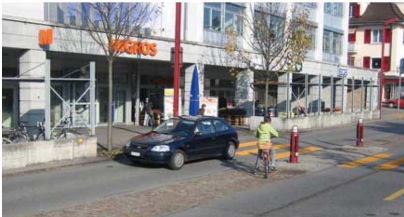
La présence d'un îlot permet aux cyclistes de se mettre en ordre de présélection et de traverser la chaussée en deux temps. À noter aussi la bordure de trottoir aménagée sous forme de rigole (Bernstrasse, Zollikofen, BE).
