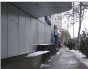
Ce chemin le long d'une façade borgne n'est pas accueillant.
