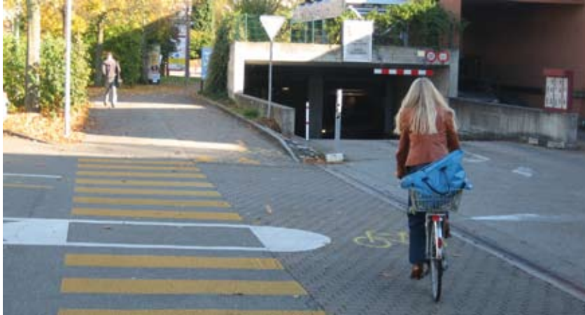
Une traversée sûre pour les piétons et pour les cyclistes est aménagée à la hauteur de l'entrée du parking souterrain (centre Ziegelei, Zollikofen, BE).
