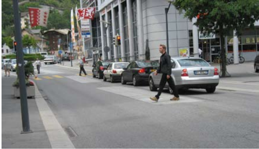
Le rétrécissement de la chaussée à la hauteur des commerces offre plus d'espace aux piétons. Le trafic reste fluide, même avec près de 20 000 véhicules / jour (Viège, VS).
