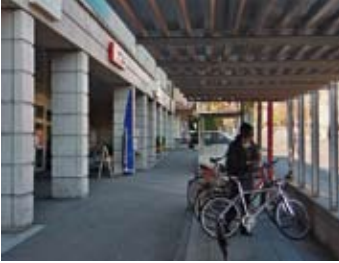
Mit einem Veloabstellplatz unmittelbar beim Eingang kann ein ungeordnetes Abstellen verhindert werden (Zollikofen BE).
