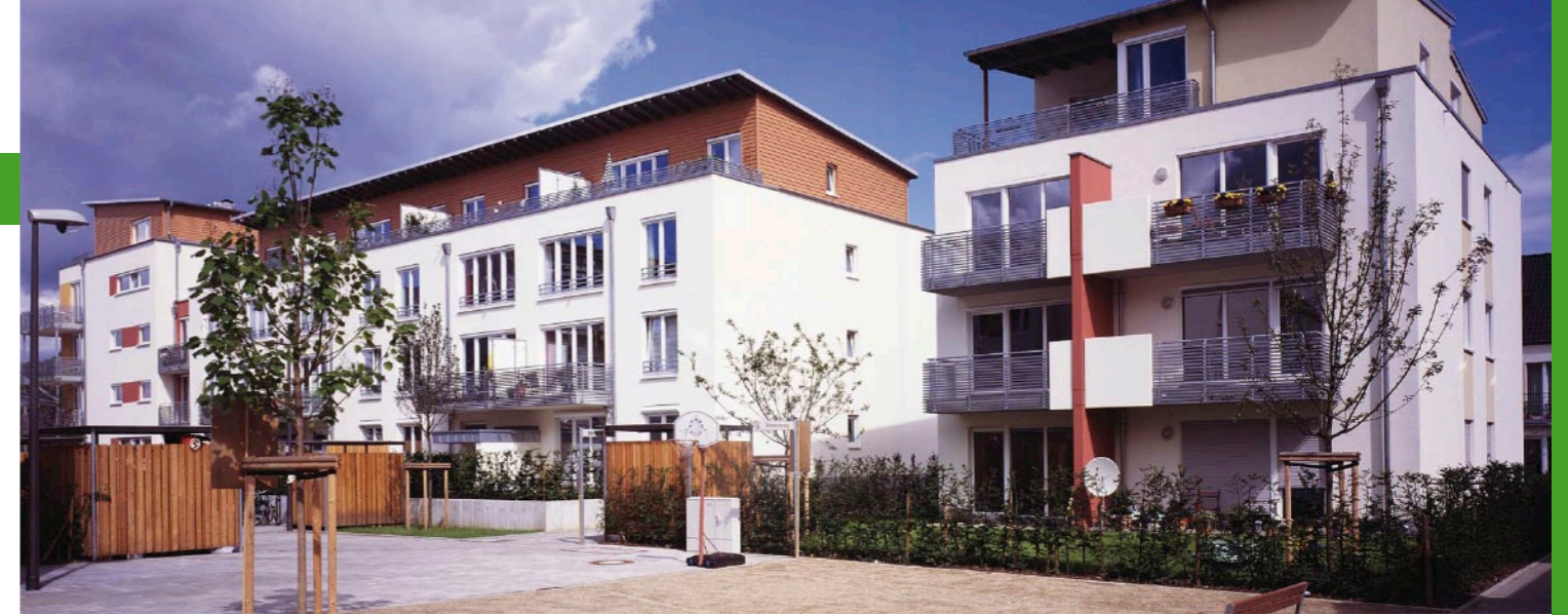
In der autofreien Siedlung Stellwerk60 in Köln sind Wege und Plätze bewusst geschaffene Lebensräume mit Kommunikations- und Verweilmöglichkeiten. Foto: Kontrola Treuhandgesellschaft mbH, 2007
