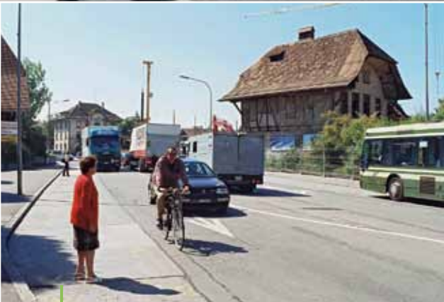
Tempo-30-Zone in Köniz: Bläuackerplatz mit Scherzhaus rechts heute (oben) und vor der Umgestaltung (unten).
