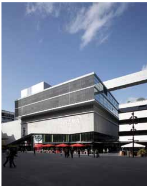
Das Einkaufs- und Erlebniszentrum Sihlcity in Zürich musste zur Erlangung der Baugenehmigung Mobilitätsmanagement in die Planung integrieren. Quelle: Sihlcity AG
