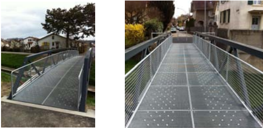
Reconstruction de 2 passerelles
