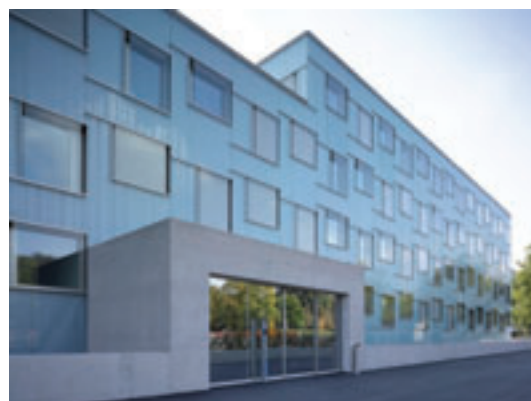
Bâtiment administratif Expo, construit selon les objectifs de performance énergétique SIA (Meier Leder architectes, photo: Roger Frei)
