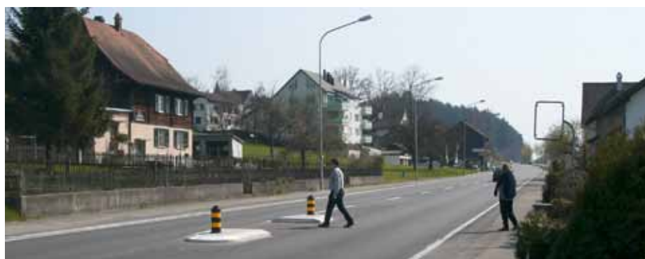
La présence d'un îlot-refuge, avec ou sans marquage de passage piéton, apporte selon la synthèse des études une bonne sécurité (photo Mobilité piétonne)
