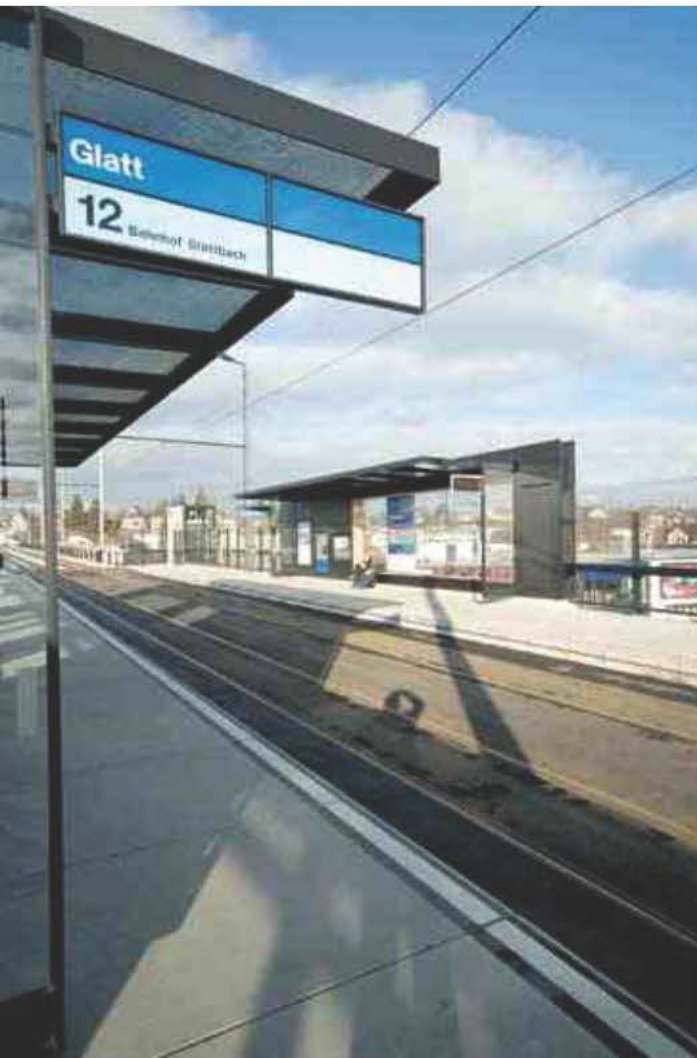
^49_Glattalbahn: Die Gestaltung der Haltestellen mit ihren behindertengerechten Hochkanten prägt das ganze Netz.
