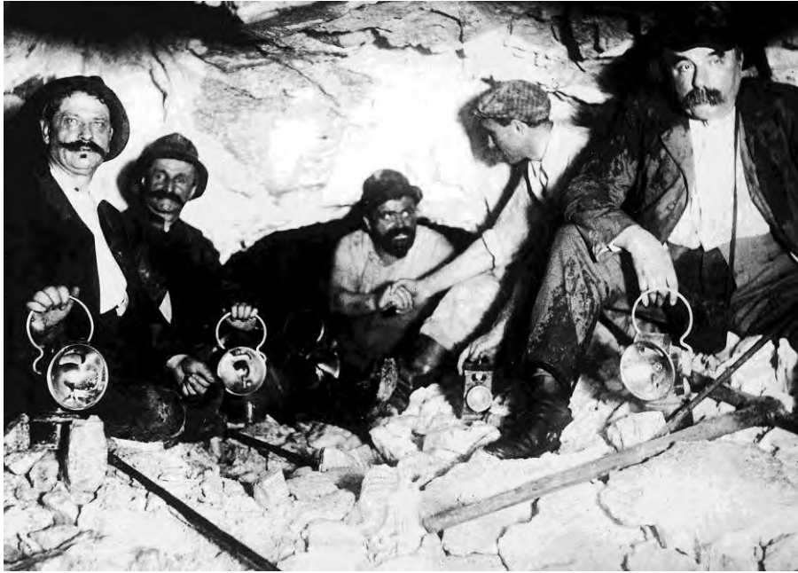
Mineure feiern den Durchstich durch den Lötschbergtunnel am 31.3.1911
