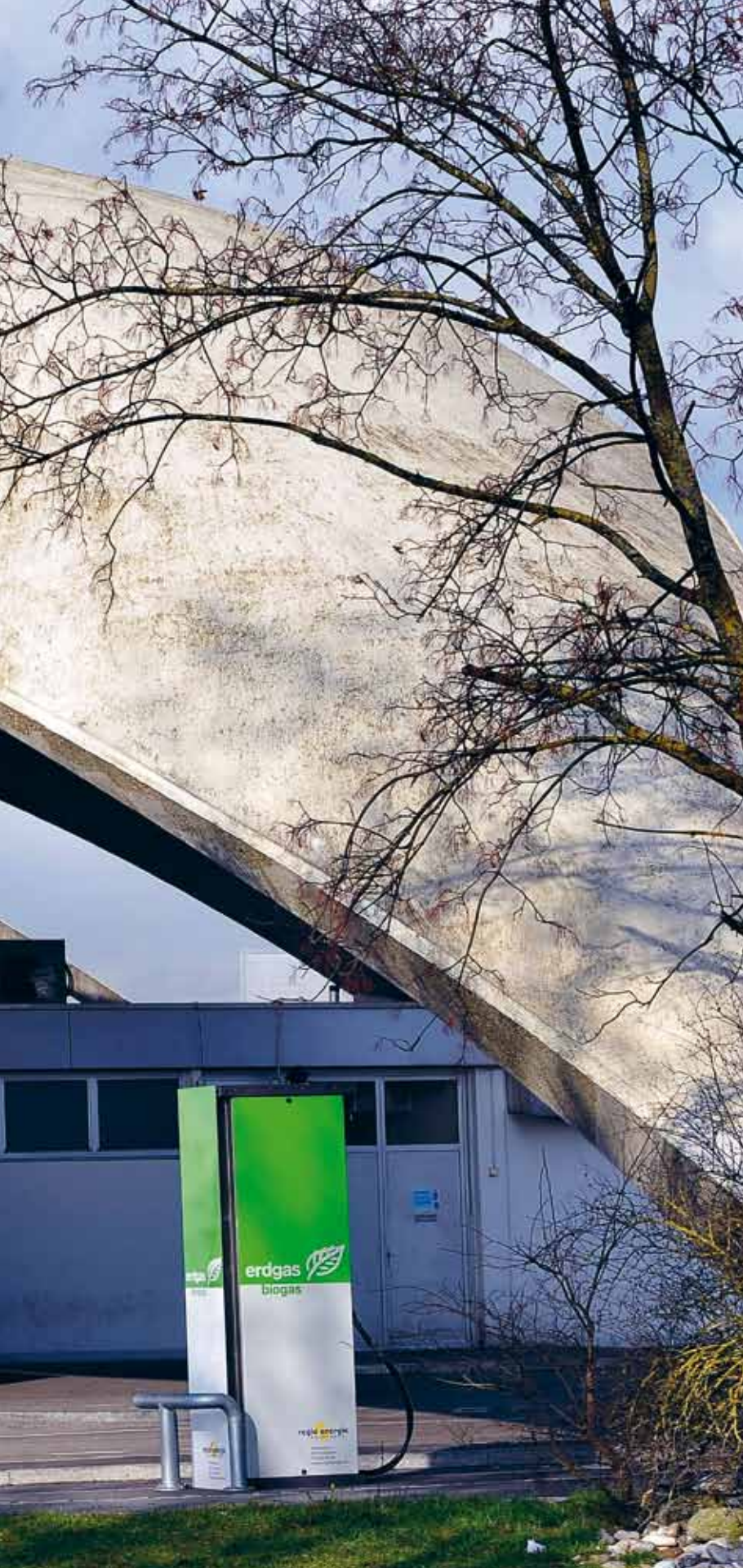
Les coques de béton couvrant le relais routier de Deitingen sont l'expression du début de l'ère autoroutière.
