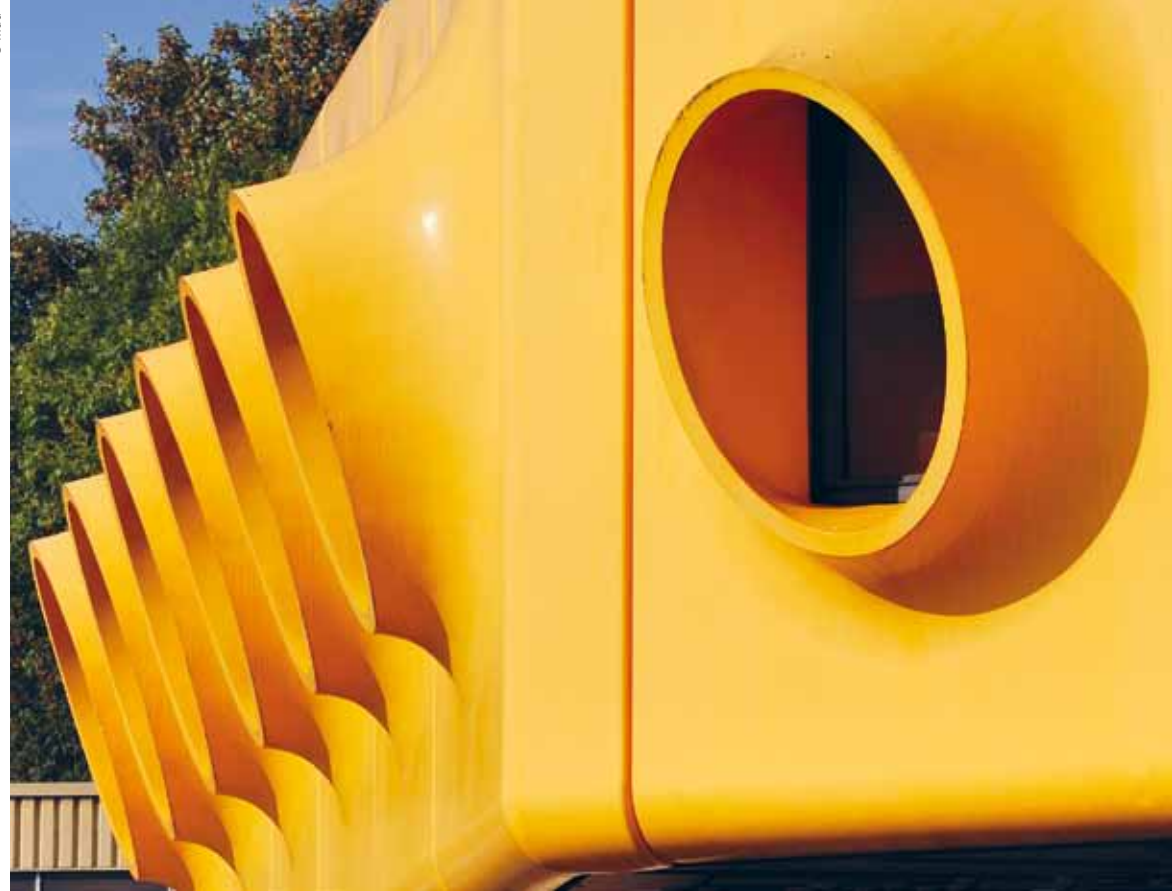
Le pont surplombant l'autoroute près de Bâle ne passe pas inaperçu, il fait penser à un sous-marin.
