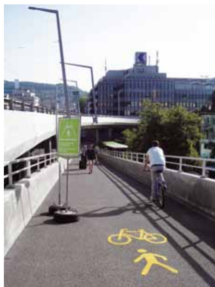
Une liaison mixte piétons-vélos relie la gare de Hardbrücke et le quartier au nord des voies. Le panneau invite les usagers à une attention réciproque. Photo: Dominique von der Mühl.
