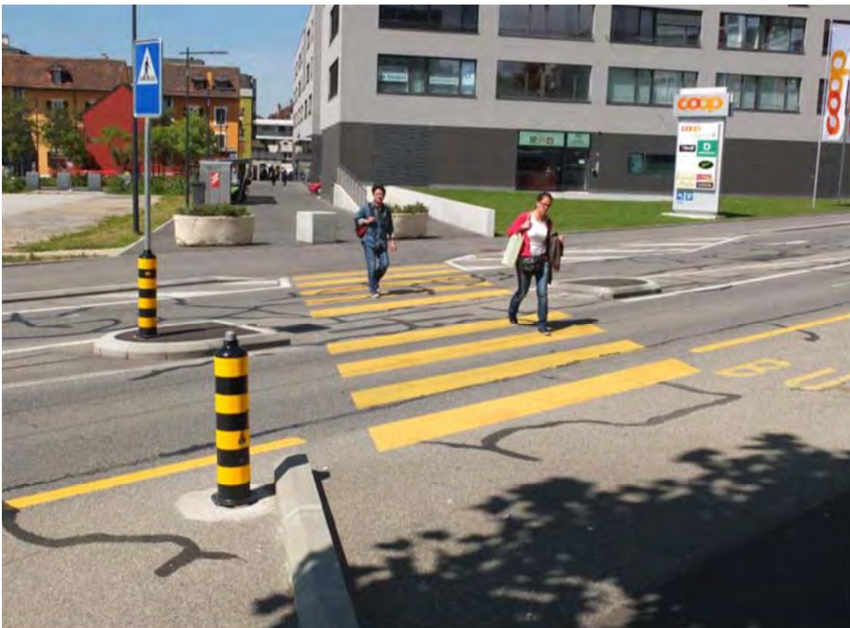
Avenue du 14-Avril / liaison piétonne «aérienne» 1
