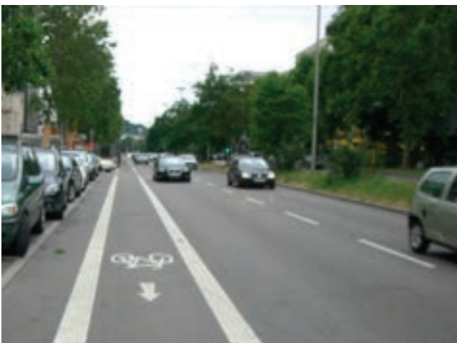
Radfahrstreifen in einer städtischen Hauptverkehrsstraße
