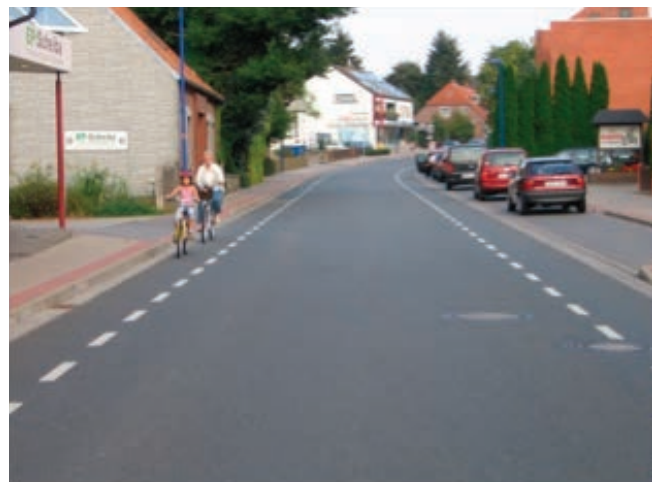
Schutzstreifen in einer ländlichen Ortsdurchfahrt
