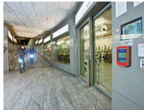
07-4.0 Zone d'accès vaste entre la rampe et l'entrée de la vélostation
