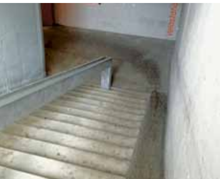
06-4.0 Solution insatisfaisante: escalier raide avec rampe étroite pour pousser le vélo, impraticable avec une remorque.
