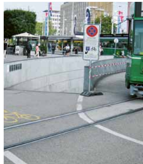
04-4.0 Accès avec une traversée de voie de tram non sécurisée
