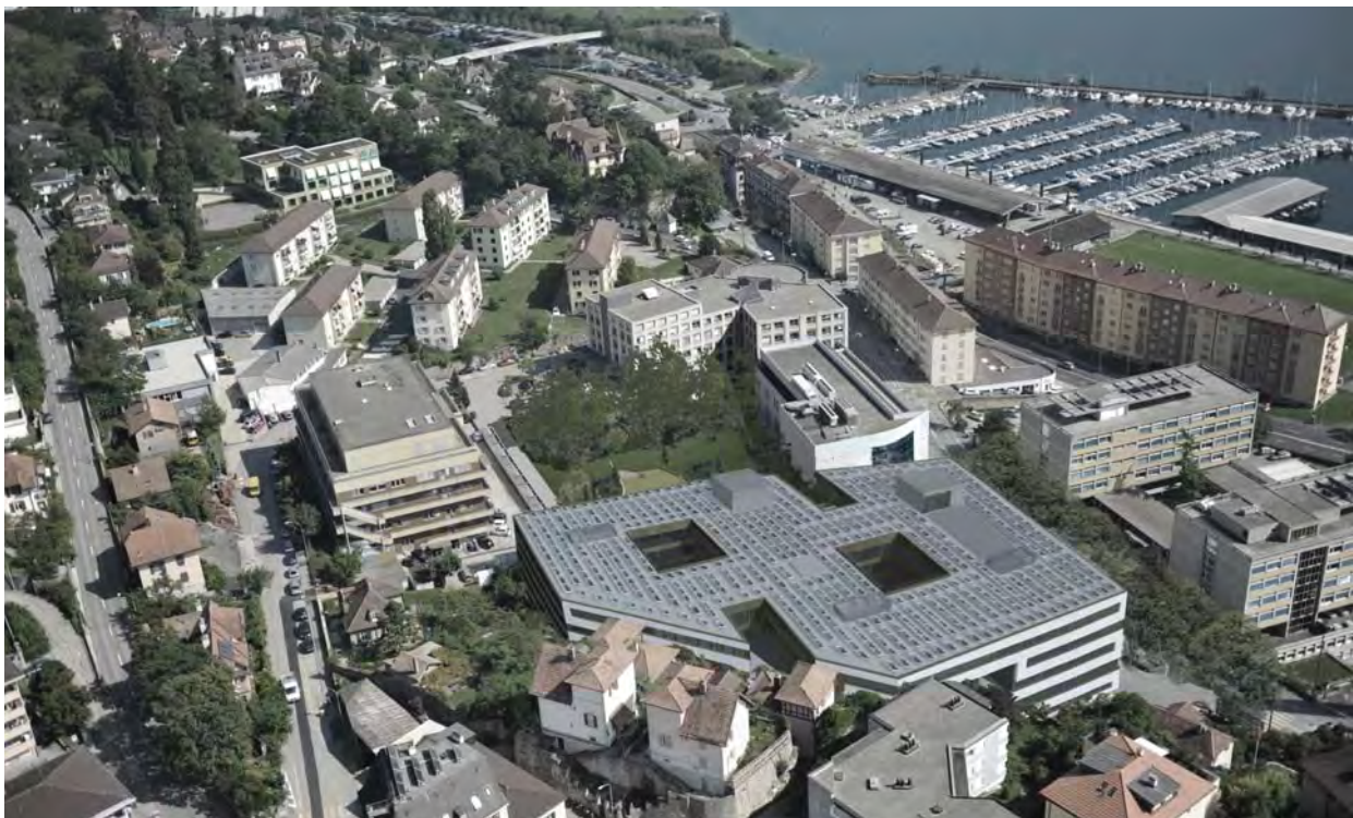
Microcity à Neuchâtel avec centrale photovoltaïque en toiture et boucle de rafraîchissement par l'eau du lac (Bauart 2013)
