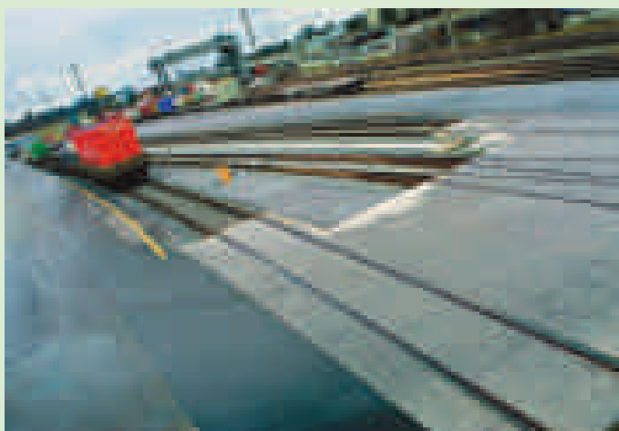
E2.2 Gleisanlage Güterbahnhof Wolf
