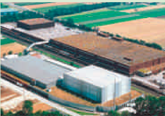
C2.4 Non-Food Lager Migros Neuendorf mit Bahnanschluss
