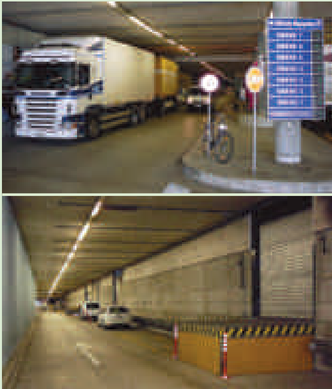
A3.2 Unterirdische Anlieferung Sihlcity, Zürich
