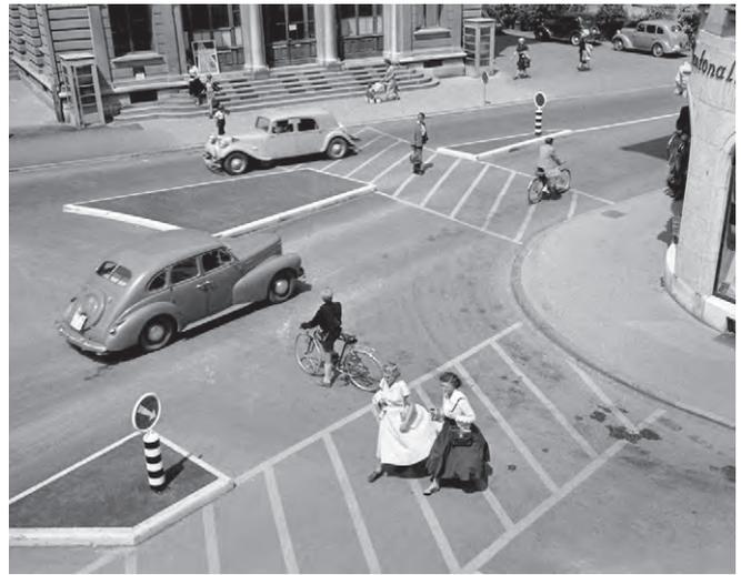
Abb. 26 und 27: Ein Fussgängerstreifen aus der Anfangszeit in Luzern 1948 (Abb. links). Die weissen Schuhabdrücke leiten die Passanten zum korrekten Überqueren der Strasse über den nur mit Eisennägeln markierten Fussgängerbereich an. Bereits durchgehend mit Farbe markiert sind dagegen die Fussgängerstreifen in Interlaken von 1953 in der Abbildung rechts. (Fotoarchiv bfu)
