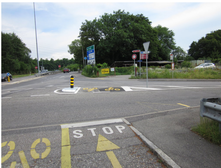
Illustration 5: Traversée de la Voie-des-Traz. L'îlot central à été réalisé récemment, suite à nos réclamations. Mais aucun marquage au sol ni panneau ne signale aux autos la traversée possible de vélos et piétons. Les piétons allant au Grand-Saconnex doivent traverser pour continuer sur le trottoir en face, mais aucun passage piéton ne leur permet de le faire en sécurité.
