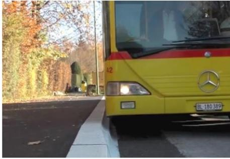
Um im abgesenkten Zustand eine Türöffnung zu ermöglichen und Schäden an der Karosserie, an den Pneu und an den Türen zu vermeiden, sind bei hohen Kanten spezielle, gestufte Randsteine notwendig (vgl. Kapitel 3.2). Eine Aufrundung an der Basis des Randsteins schont die Reifen und ermöglicht, das geforderte Spaltmass einzuhalten. Aus diesen Gründen sind auch für die Anfahrt Randsteine mit Spurführung zu empfehlen (mit reduzierter Höhe).
