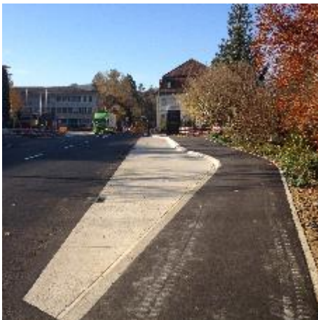
Figure 8: Bordure d'accostage haute avec «avancée» (photo: canton de Bâle-Campagne)
