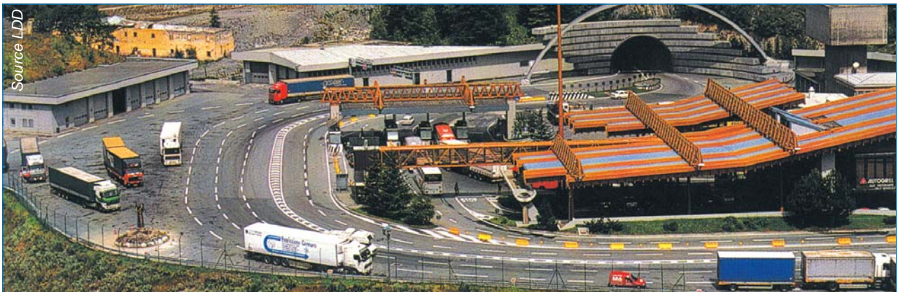
Plateforme italienne du Tunnel du Mont-Blanc - Italian entrance to Mont-Blanc Tunnel
