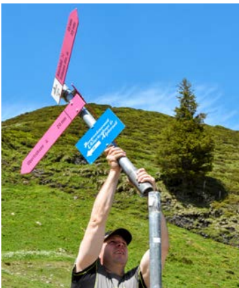
Abb. 15 Wegweisermontage mit Kopfwechselsystem
