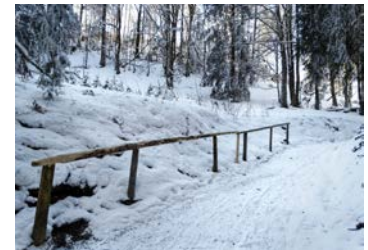
Abb. 6 Steile, teilweise vereiste Wegpassage mit Geländer und Splitt gesichert
