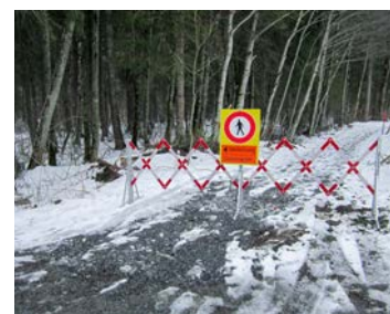
Ill. 24 Fermeture d'un chemin de randonnée hivernale au moyen d'une barrière extensible
