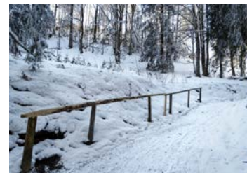
Ill. 6 Passage en pente raide et partiellement gelé, sécurisé au moyen d'une barrière et de gravillons au sol
