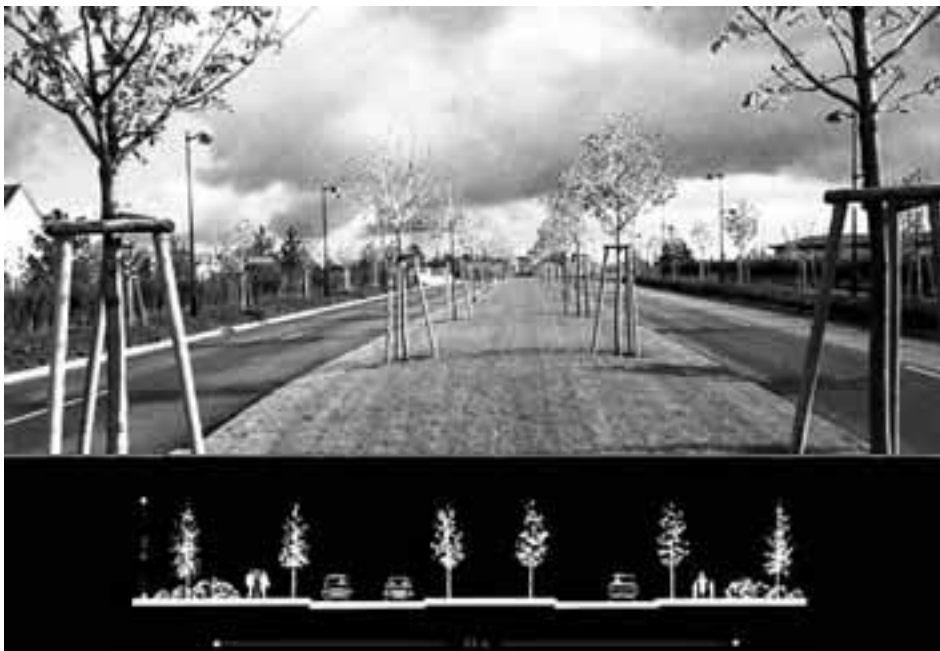
Avenue plantée à Eurodisney, illustrant l'esprit dans lequel l'A1 pourrait être requalifiée en boulevard urbain entre l'échangeur d'Ecublens et le giratoire de la Maladière
