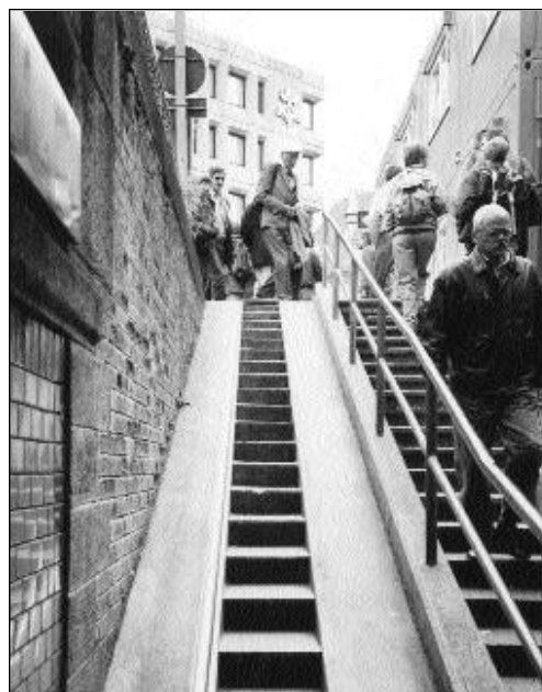
ILLUSTRATION 15 Rampe pour vélo dans un escalier Winterthur (Suisse)
